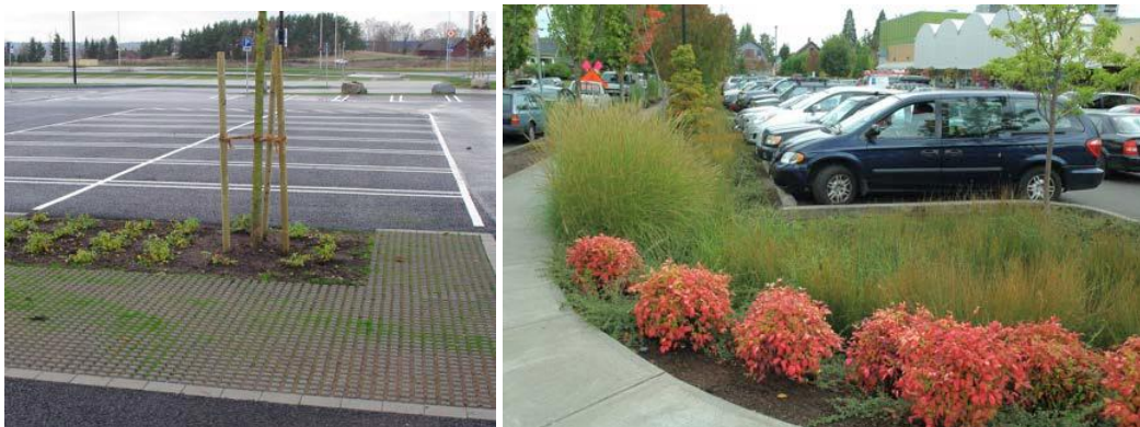
Genomsläpplig beläggning och växtbäddar vid bilplatser och parkeringar
