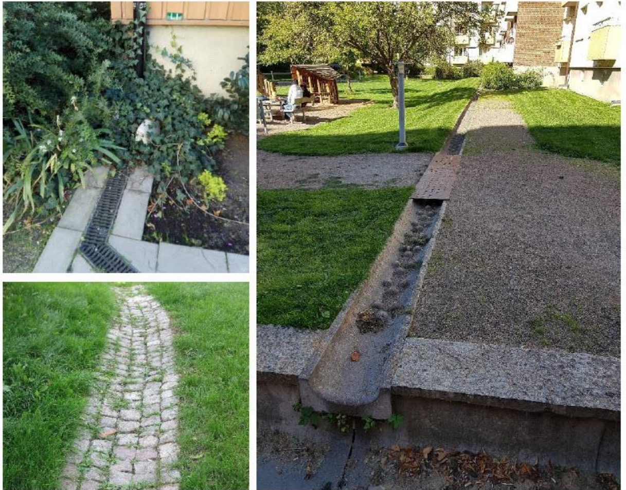
Figur 27. Exempelbilder på olika typer av rännor för ytlig avledning av takvatten (Foto: Tyréns)
